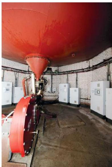
Применяемые современные материалы по химической защите чаши сгустителя позволяют использовать аппарат для осветления и сгущения горячих пульп с температурой до 105°с.
