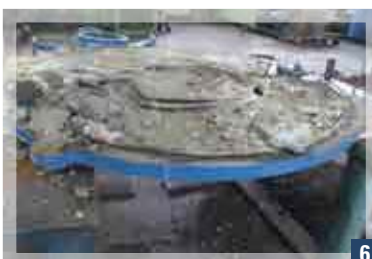
6 Disco distributore intasato. Clogged port plate.
