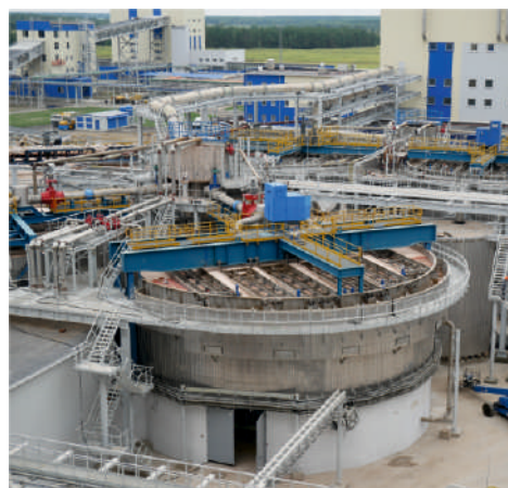
На фото: отделение сгущения Петриковского ГОКа (проектная мощность по руде – 7 000 000 тонн в год, по готовому продукту – 2 000 000 тонн в год)
