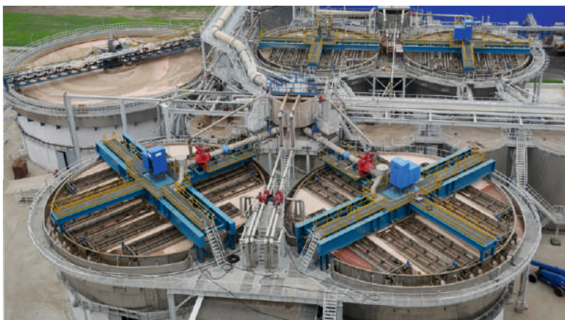
На фото: отделение сгущения Петриковского ГОКа (проектная мощность по руде – 7 000 000 тонн в год, по готовому продукту – 2 000 000 тонн в год)
