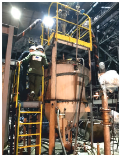
ТОФ-2ПК ПАО «Норникель»: установка флотационная опытная
